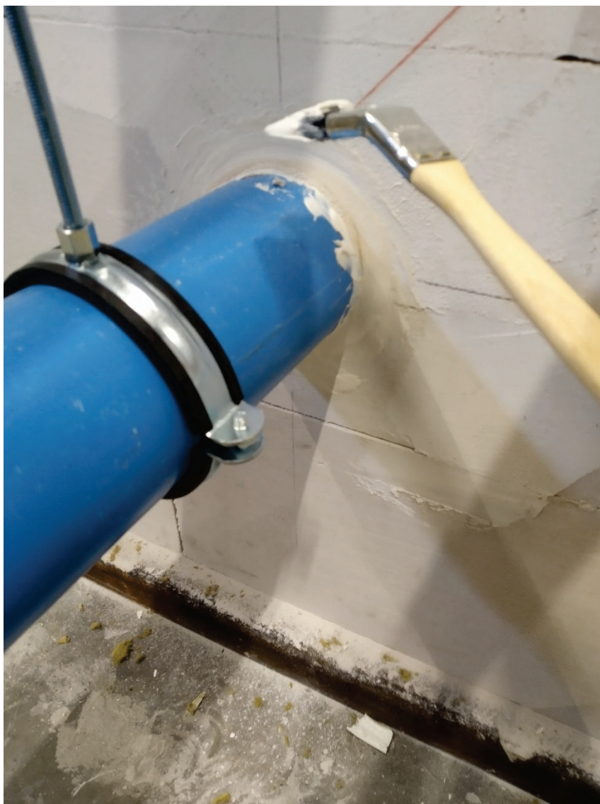
Foto 2 Aanbrengen van de HPS Steenwol verf
