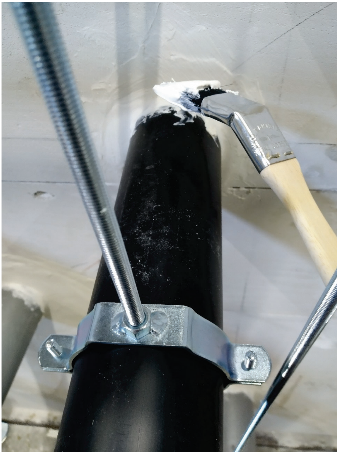
Foto 1 Aanbrengen van de HPS Steenwol verf op de afdichting van proefstuk 2
