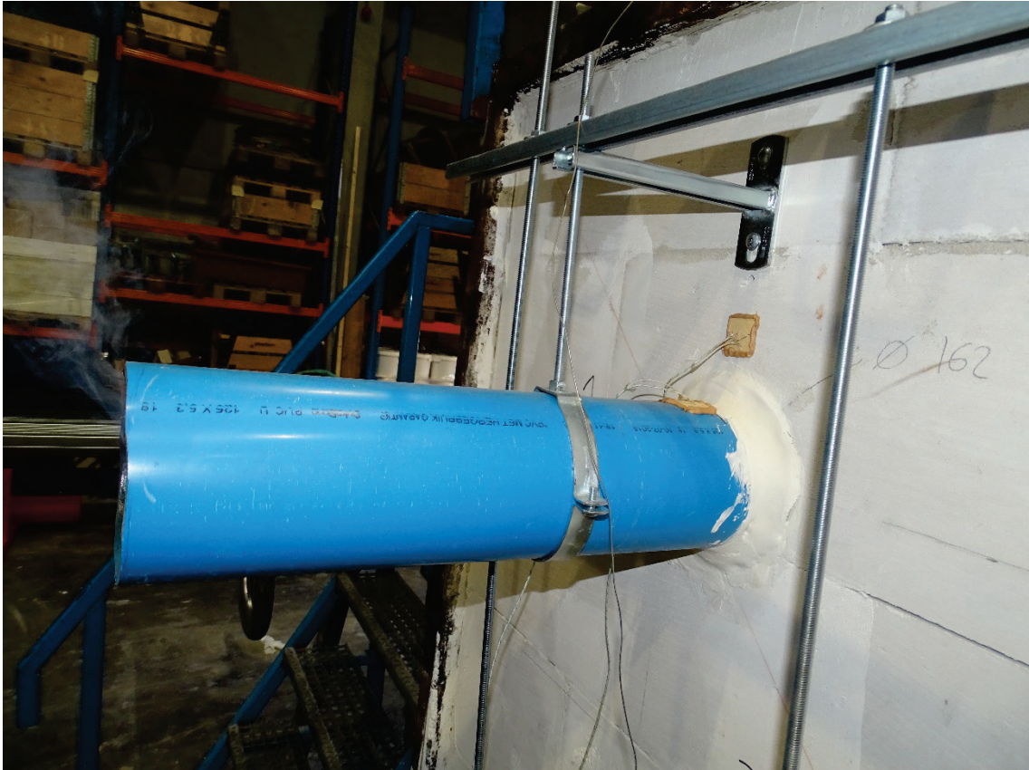
Foto 7 Proefstuk 1 na 16 minuten verhitting
