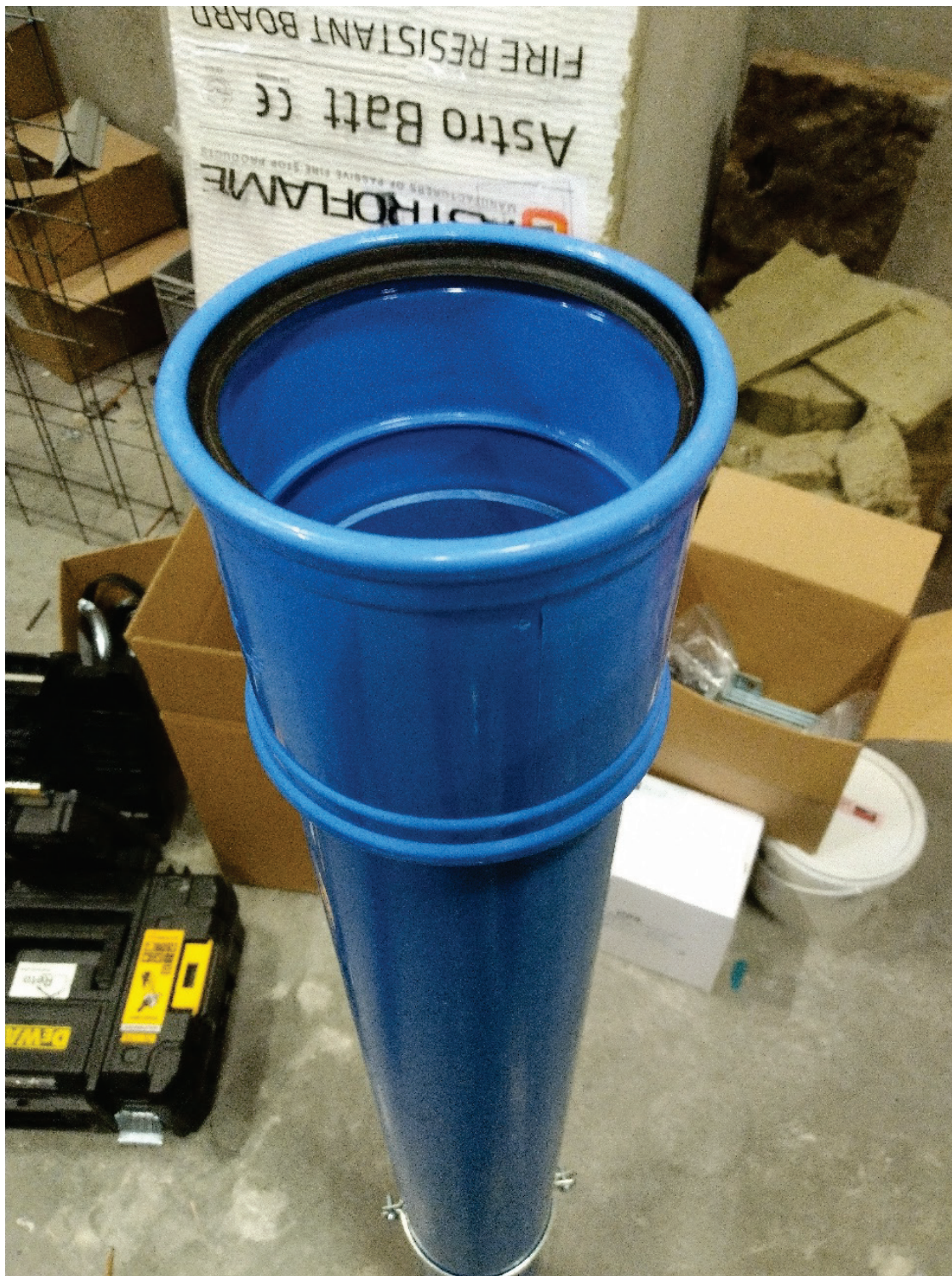
Foto 1 Koppelstuk van de Dyka Sono leiding 1
