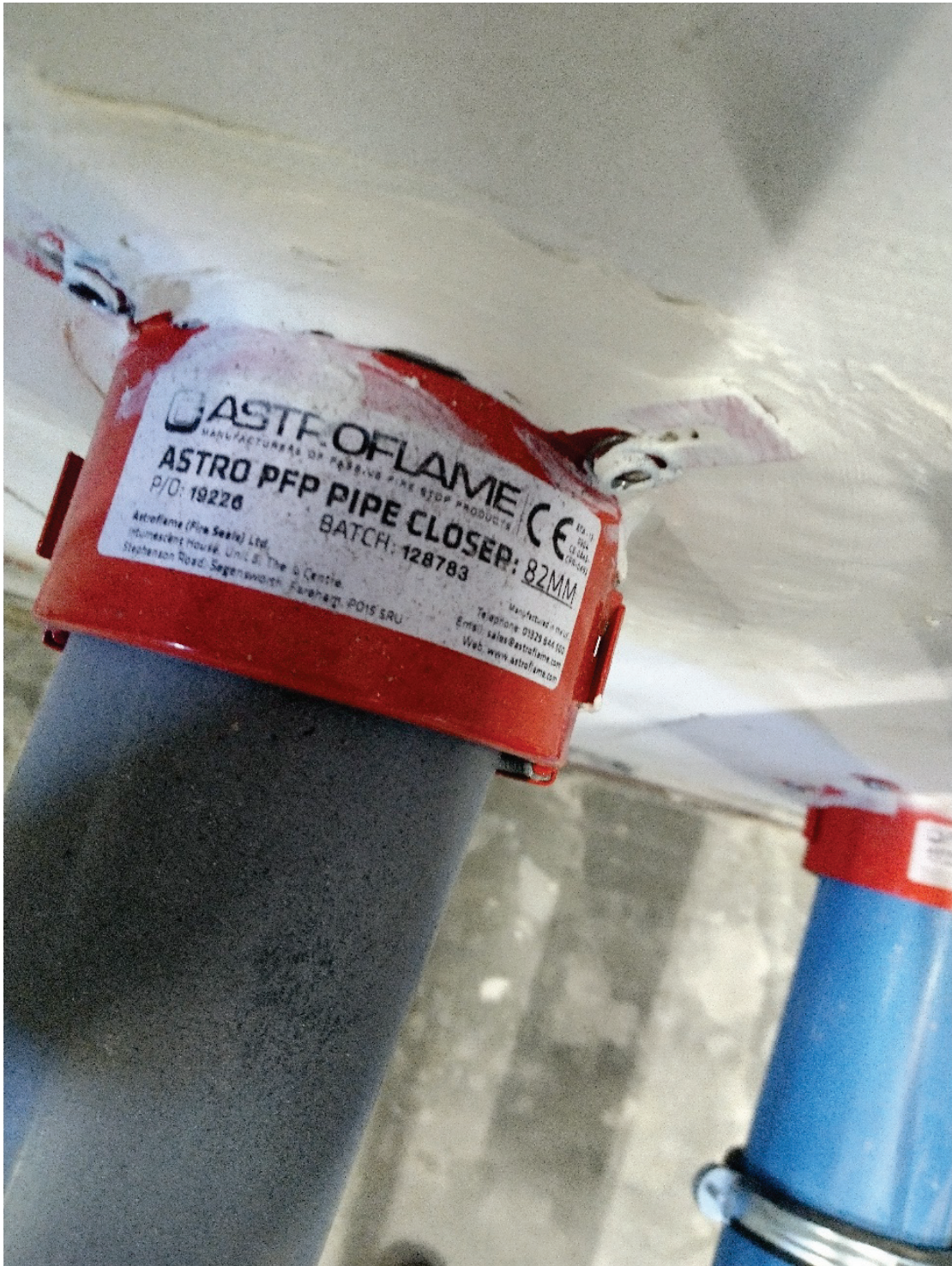
Foto 3 De aangebrachte manchet met de afwerking aan de vuurzijde
